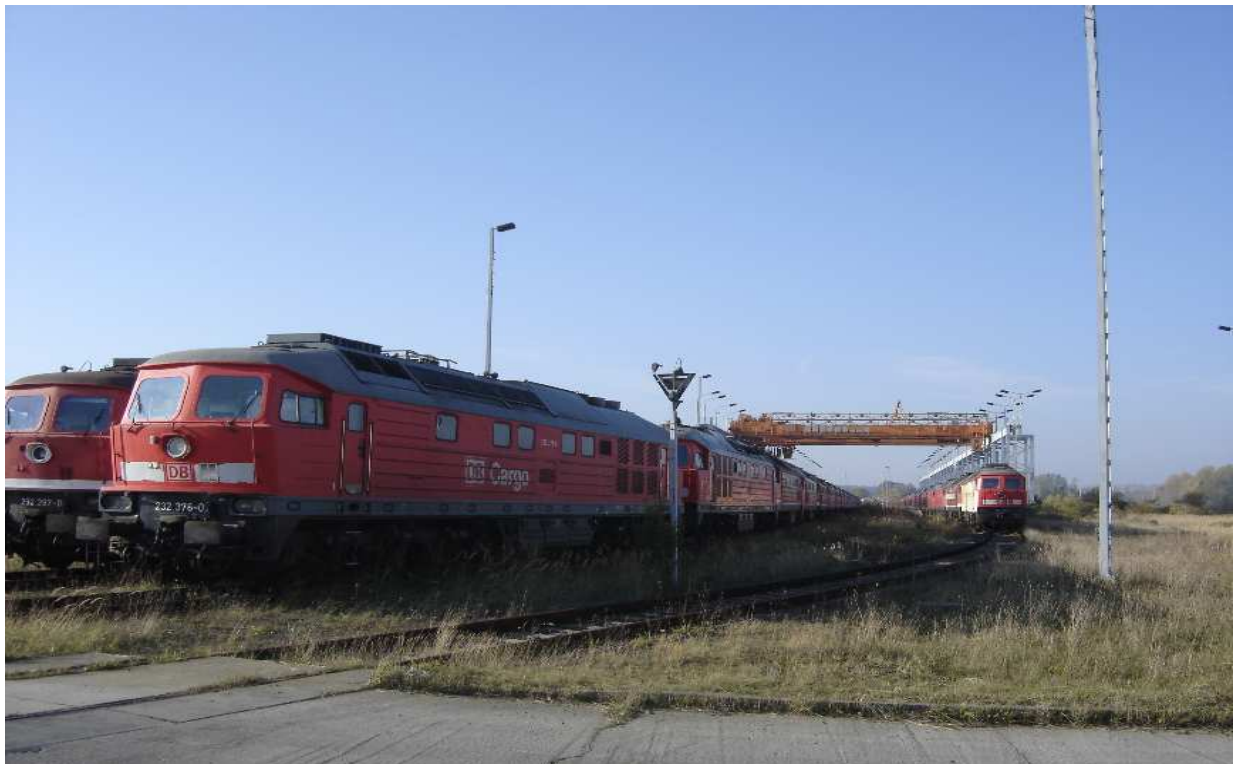
Lokfriedhof Bahnhof Mukran Rügen
